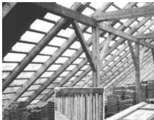
Obr. 2.20: Typické použití dřeva při zhotovování stavebních konstrukcí
