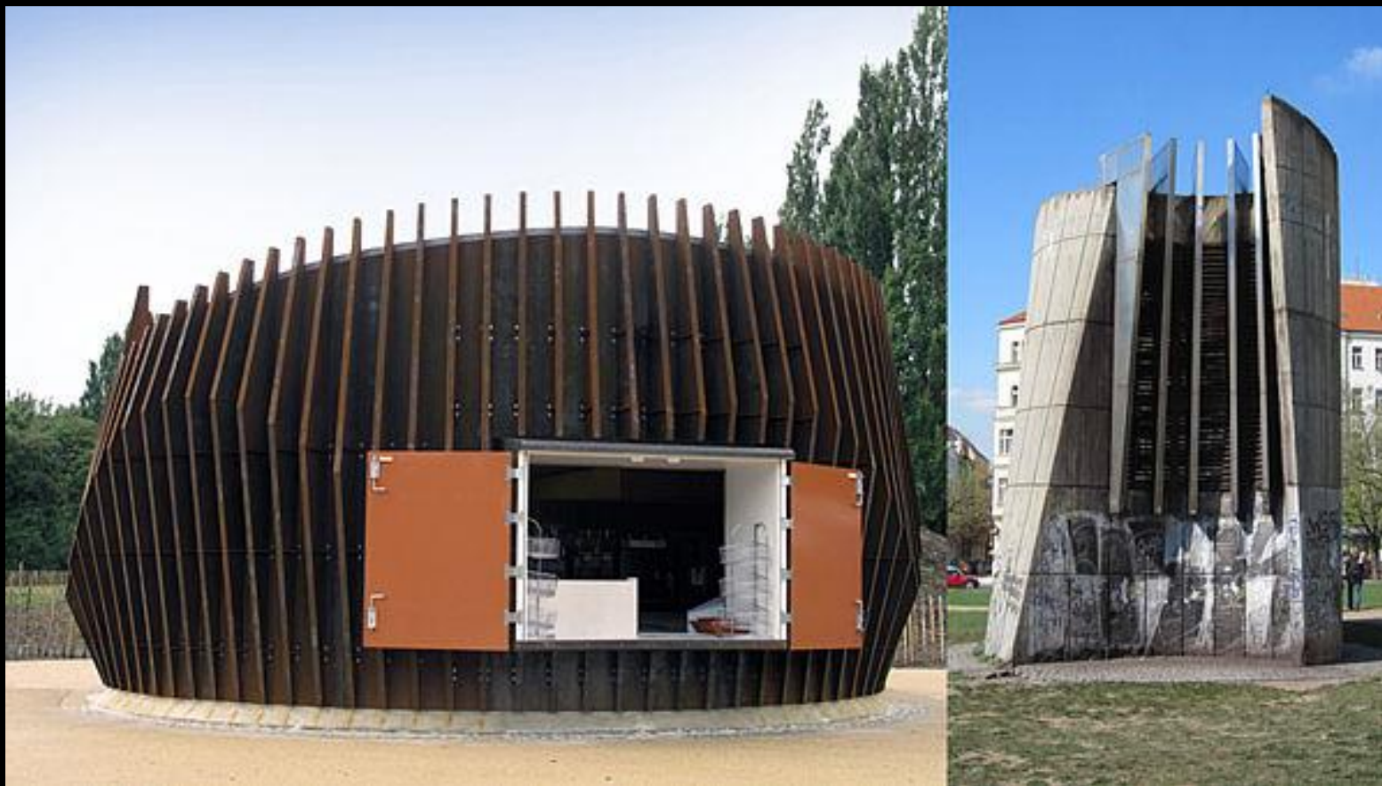
Korozní zplodiny jako součást architektonického řešení Central Park Scunthorp - Anglie
